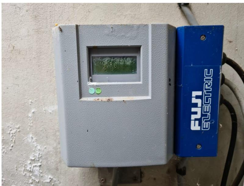
Les données de ce débitmètre ne sont pas fiables. Il doit être remplacé et recalibré afin d'obtenir une métrologie fiable. La télétransmission doit faire l'objet d'une révision.
