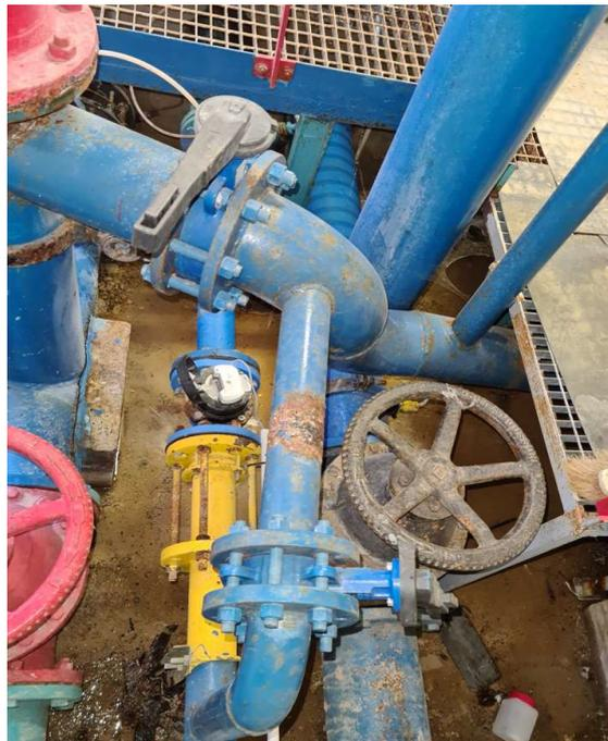
Le compteur DN 80 fonctionne mais, pour assurer une précision métrologique optimum, il est préconisé de poser en lieu et place un débitmètre électromagnétique MAG 8000 DN 80.
